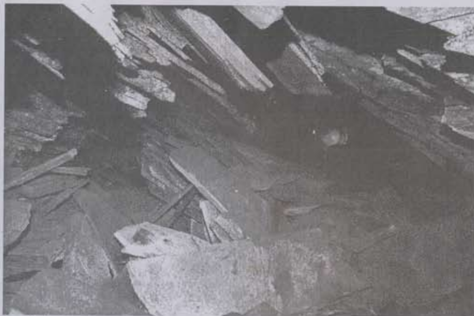
Foto 02: deslocamento de itabirito numa galeria da Mina do Chico Rei. Estes deslocamentos podem causar subsidência nos terrenos sobrejacentes.
