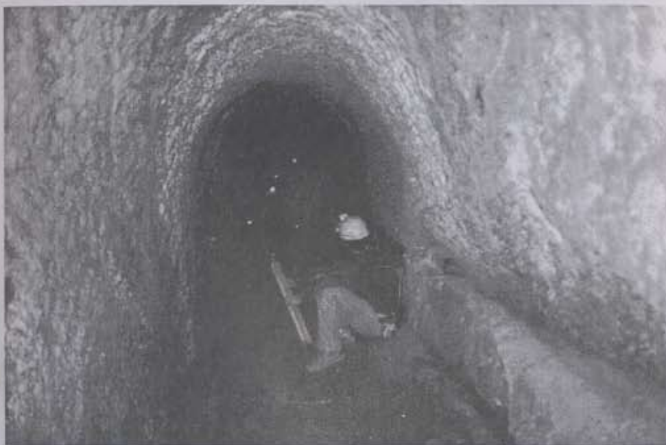
foto 01: detalhe da calha esculpida em itabirito na lateral galeria principal da Mina do Scliar.
